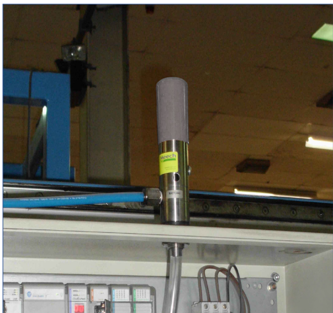
机柜冷却器可安装在电气设备面板中。
